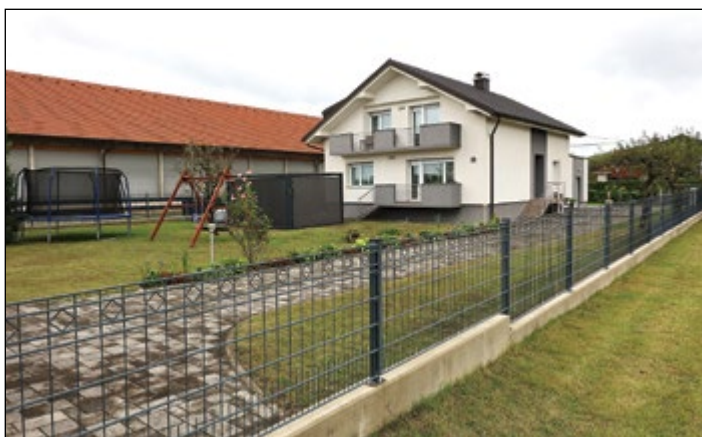
Družina Starčević - Ribič, Hajdoše 1g, prejme bronasto vrtnico za vzorno urejeno stanovanjsko hišo.
