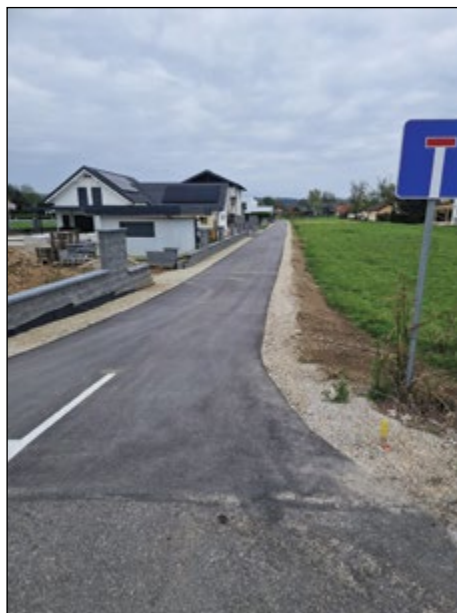
Asfaltirani odcep ceste Kolednik v Slovenji vasi
